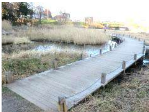
木道の補修工事は 2 年目、範囲と 工事時期を決めて前回同様に表示 水路の水は土囊 2 ヲ所で堰き止め
