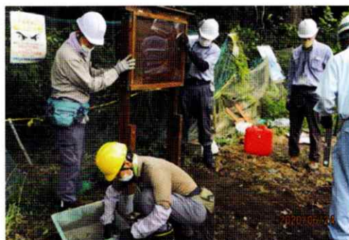
掲示板の設置作業
