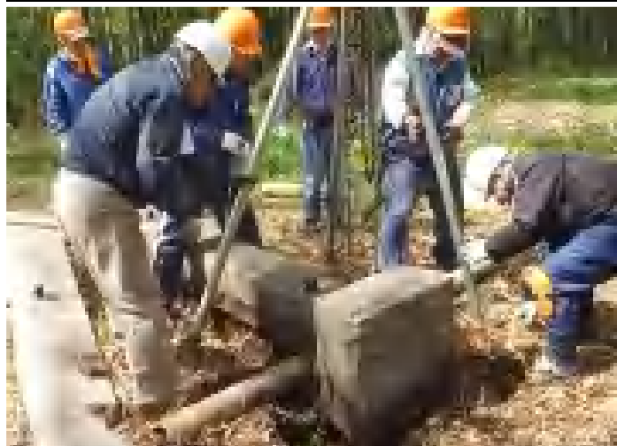
通路上に横たわる石柱が1対、3又に滑車を付けた
