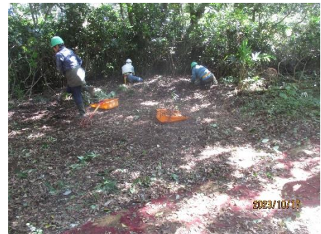
同左 仕上げ段階の様子
